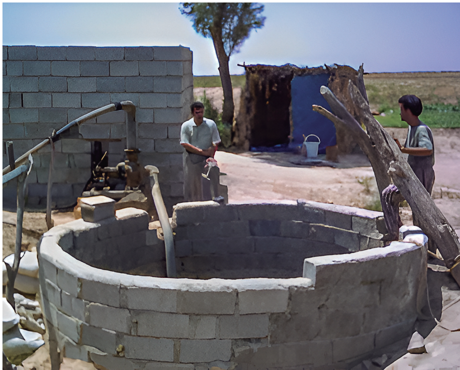
Figura 7. Pozo con pared de ladrillos, extendida sobre la superficie del suelo (adaptado de Kompani - Zare et al., 2009)
