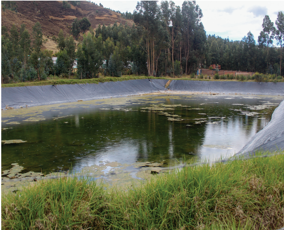
Figura 6. Reservorio revestido con geomembrana
