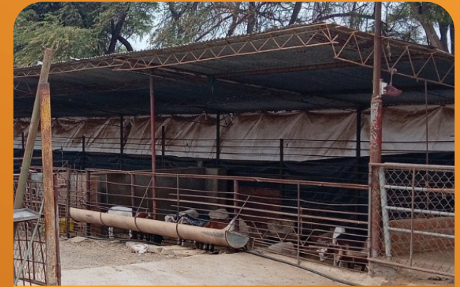
Techo de calamina.
