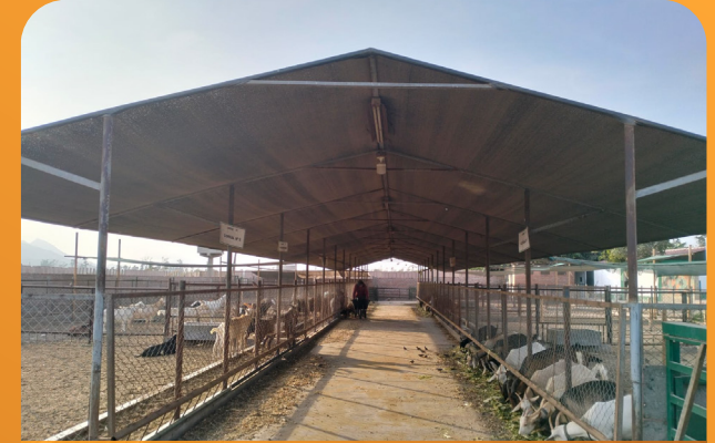
Techo de malla raschel a dos aguas.
