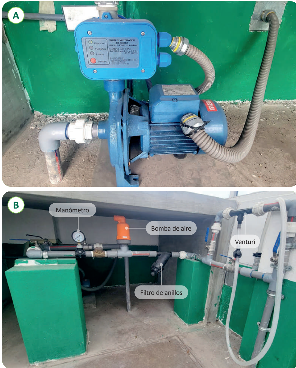
Figura 42. Arco de riego compuesto de bomba hidráulica 2 HP (A), reservorio soterrado, bomba de aire, manómetro, filtro de anillos y venturi para fertirrigación (B).
