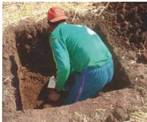
Foto 34. Productor abriendo calicata.
