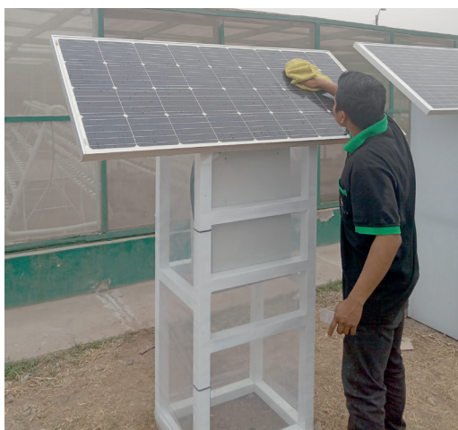
Figura 33. Limpieza del panel solar con franela
