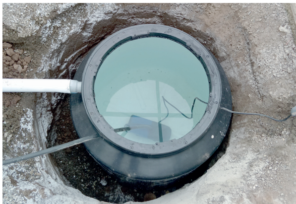
21 Siq'i. Qhipa kaq astaypaq, 250 L unu winku yaykuq lastiku mak'asmi kanan
