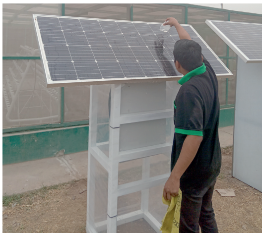
Figura 32. Limpieza del panel solar con agua
