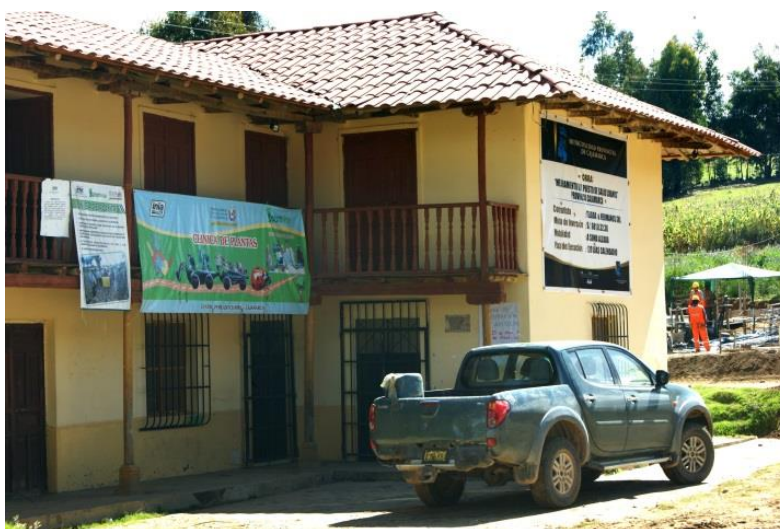
La clínica de plantas de Chamis está ubicada en el segundo piso del edificio municipal, justo arriba del puesto de salud humana.
