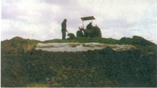
Fig. 12. Sellado del silo
