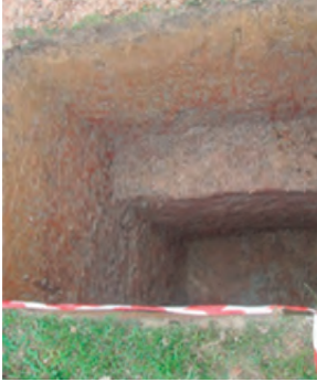
Calicata central culminada 2 x 1 m de profundidad.
