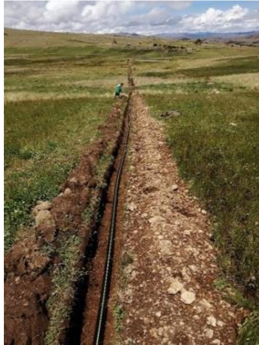
Sistemas de conducción de agua
