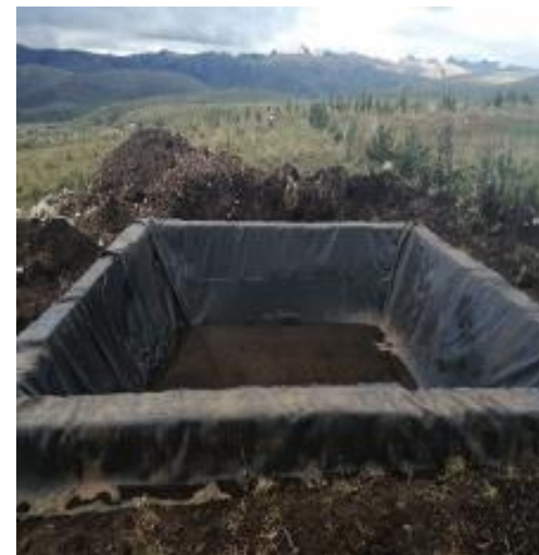
Impermeabilización del reservorio con geomembrana
