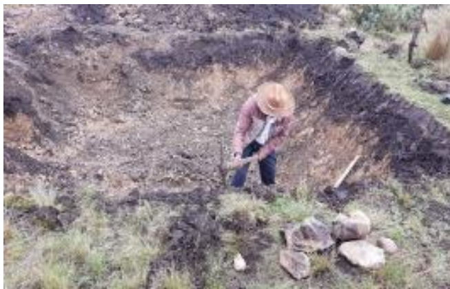
Construcción de reservorio
