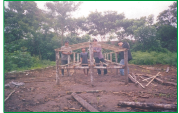
Fig. 4: Instalación de soportes de las parihuelas.
