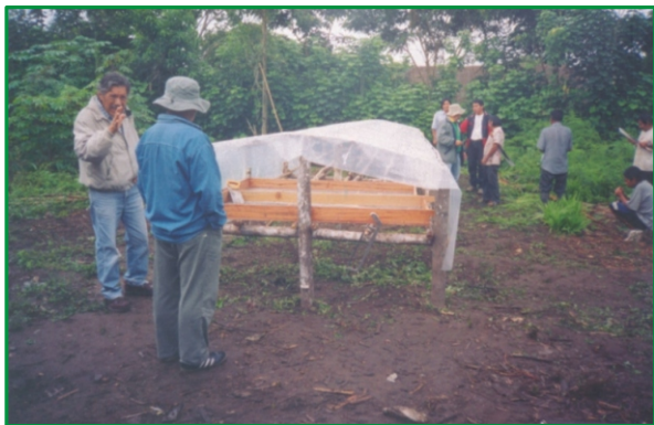
Fig. 6: Armado de las parihuelas.
