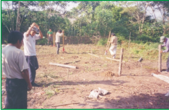
Fig. 2: Delimitación del área y apertura de pozos para instalación de postes.
